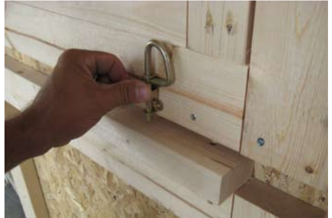
32. Install barrel bolt.
